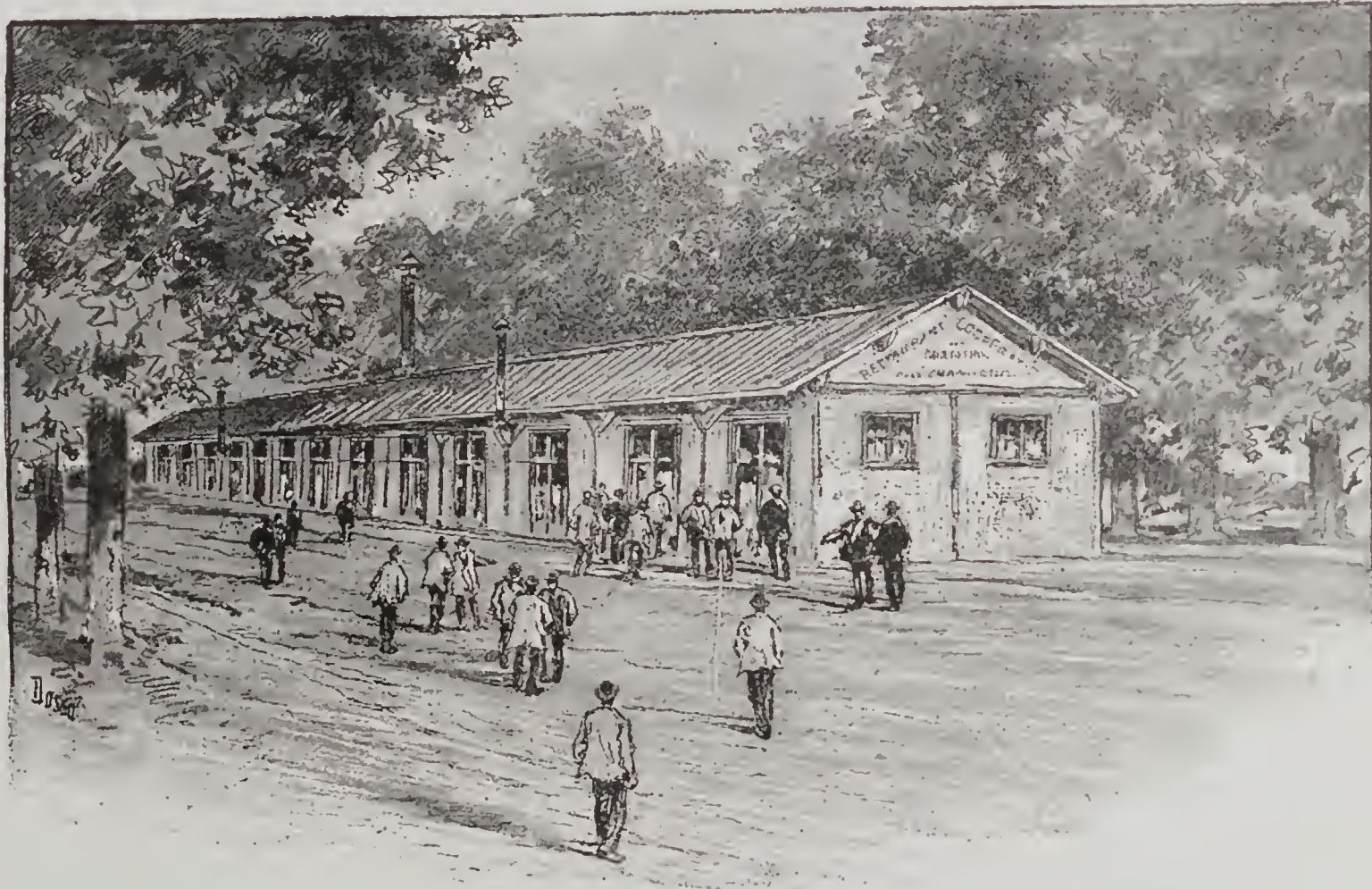
LE RESTAURANT COOPÉRATIF. — Vue extérieure de l'établissement.
